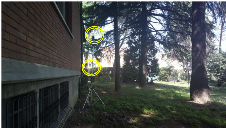
Postazione di rilievo a terra – misura rappresentativa dei futuri affacci ai livelli terra e primo della porzione di edificio in progetto.
